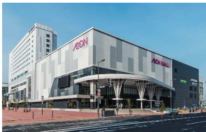
JR旭川駅ビル
